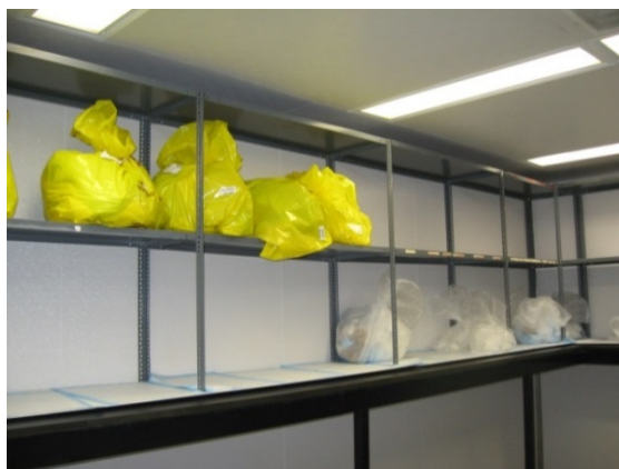
Figure 3 – Salle de décroissance de déchets radioactifs
